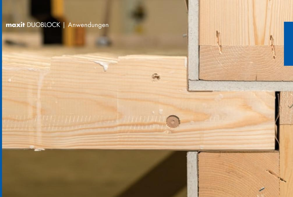
Beispiel 3) Aufnahmelager im Holzmassivbau
