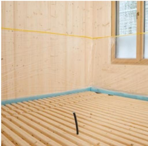
Nach Abschluss aller Restarbeiten ist die Zugzone fertig für den Verguss.
